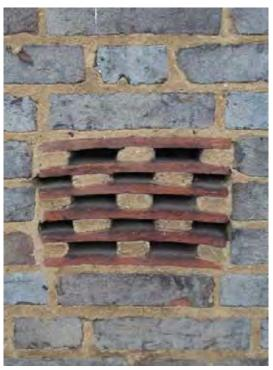
Fig. 38: Ventilation detail
